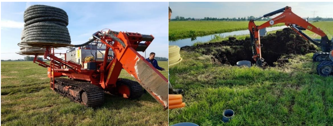
Draineer machine van Heerschap en eerste put in de Tol
